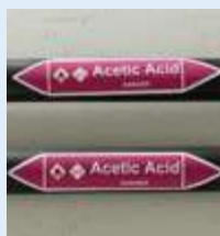
Marquage de tuyauterie
