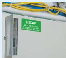
Etiquetage pour les tableaux de commande
