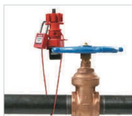
Bloquez les vannes à volants en utilisant l'attache de câble.
