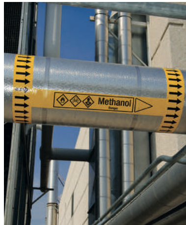
Marquage de tuyauteries
