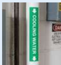
Marquage de tuyauterie
