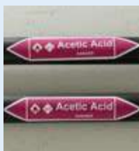
Marquage de tuyauterie
