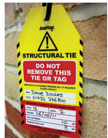
Légende: Ne pas retirer cette attache d'échafaudage
